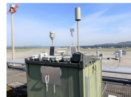
Die automatische Messstation auf dem Dach des Docks A.
