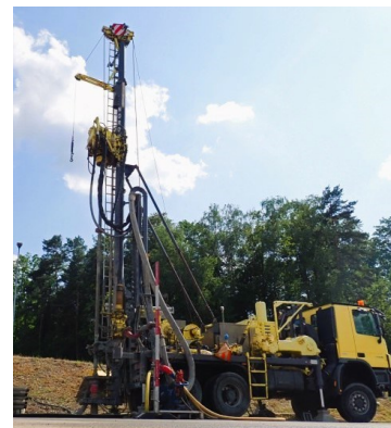
Im Berichtsjahr fanden drei Sondierbohrungen zur Erkundung der unterirdischen Rinne statt.
