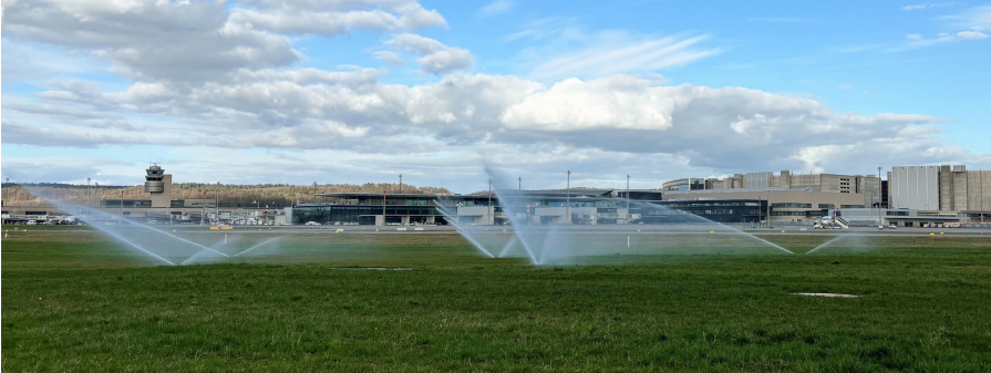
Die Verregnungsanlage versprüht mit Enteisermitteln belastetes Wasser auf Grünflächen. Bei der anschließenden Bodenpassage wird das Wasser gereinigt.
