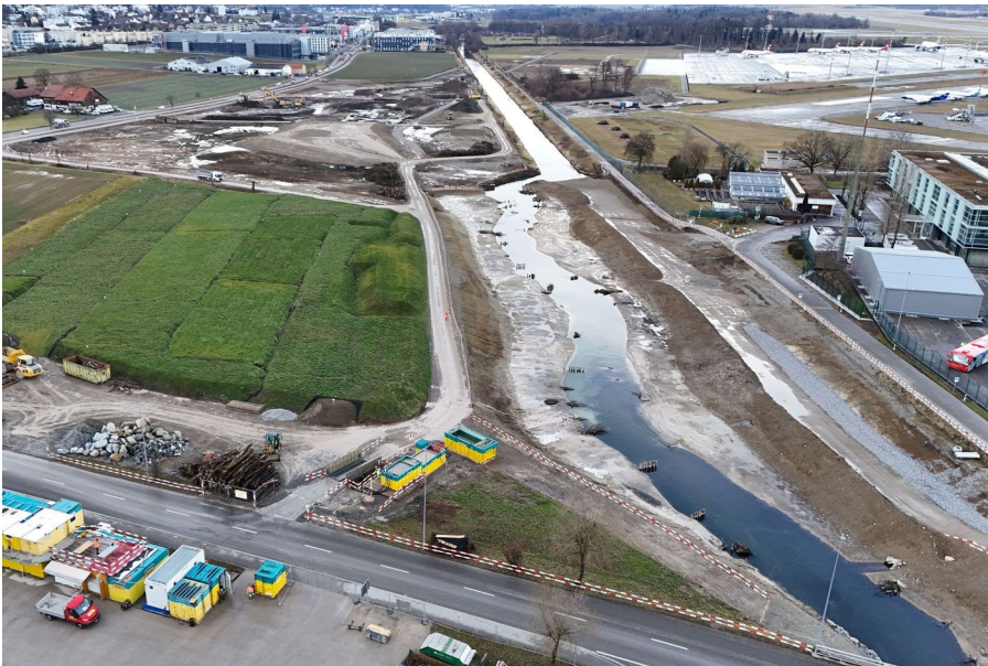
Im Vordergrund der bereits realisierte Abschnitt «Eichhof» der Glattrevitalisierung und im Hintergrund die aktuelle Baustelle des nächsten Abschnitts.
